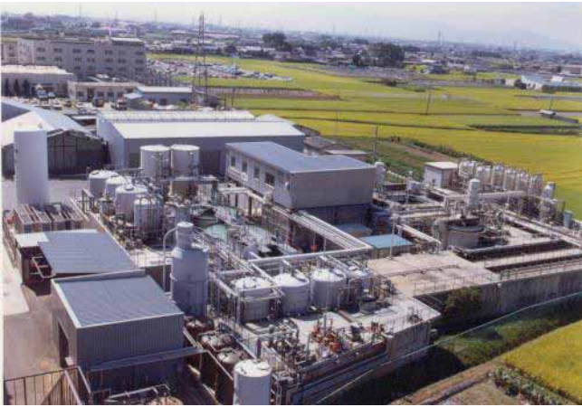
Ảnh: thiết bị xử lý nước thải từ chế tạo linh kiện điện tử
